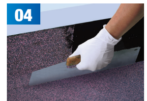
04 Homogene en naadloze afwerking met leislag, granulaat of Alsan Curfer .
