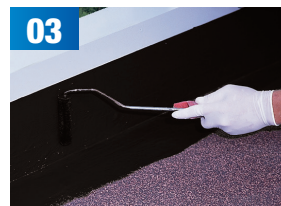
03 Aanbrengen van de volgende laag Alsan Flashing Jardin
