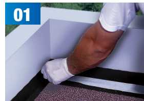
01 Losse leislag met staalborstel verwijderen en een eerste laag Alsan Flashing Jardin aanbrengen waarin het versterkingsvlies wordt gekleefd.
