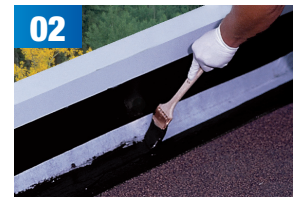
02 Versterkingsvlies inwerken met Alsan Flashing Jardin
